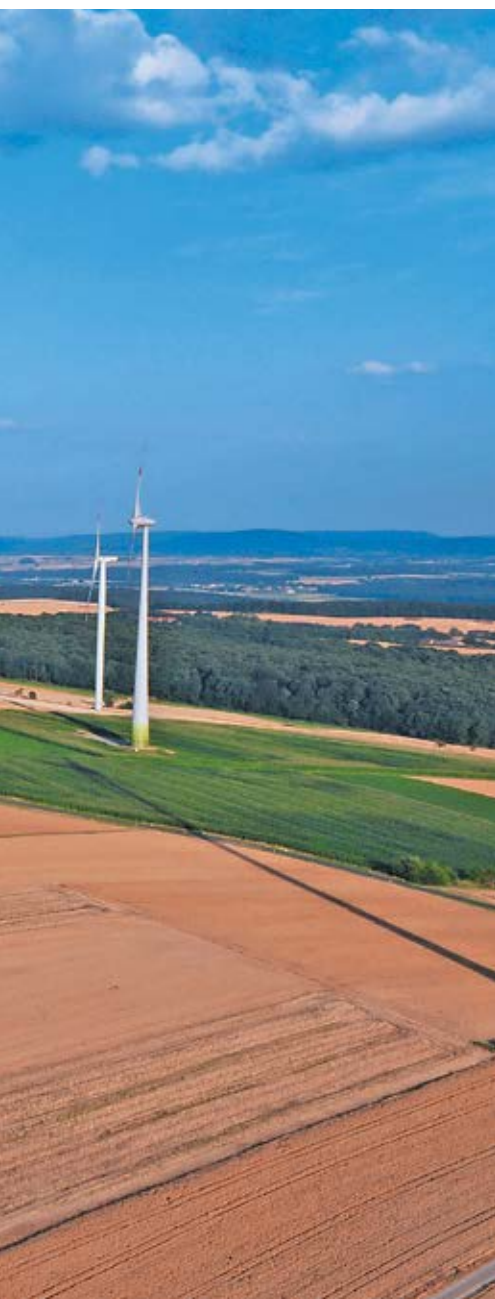
Blick in den Windpark Schonungen im Landkreis Schweinfurt.
