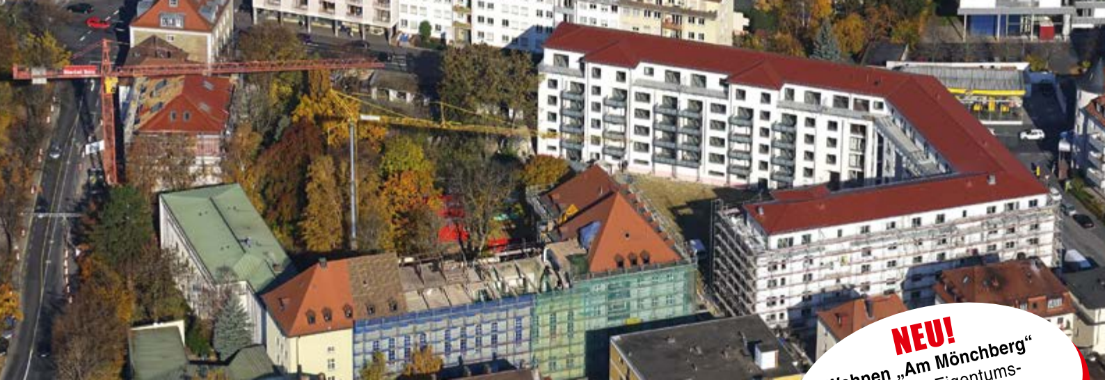
Neubau des Bauträgerprojektes „Wohnen am Platz'schen Garten“ in Würzburg im November 2015 (alle 95 Wohnungen sind bereits verkauft).
