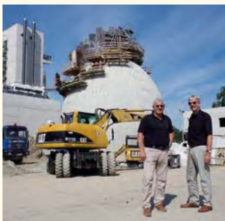
Werkleiter Professor Christian Baumgart (re.) und stellvertretender Werkleiter Jörg Roth (li.) vor einer der beeindruckendsten Baustellen. In der Mainaustraße baut der Entwässerungsbetrieb eine neue Anlage zur Aufbereitung von Klärschlamm und zur Produktion von Gas und Strom. Foto: Claudia Penning-Lothar
