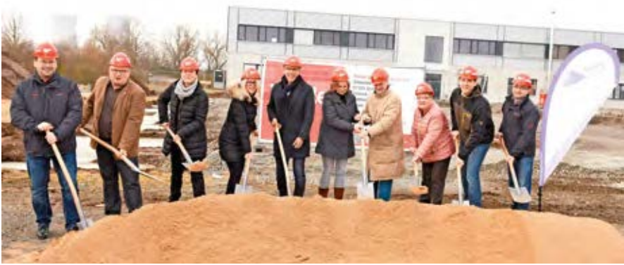
Beim ersten Spatenstich im Bild (v. l.): Veit-Gerald Hermann (Projektleitung Riedel Bau), Klaus Marder (Leiter schlüsselfertiger Industrie- und Gewerbebau Riedel Bau), Stefanie Riedel (Aufsichtsratsvorsitzende Riedel Bau), Caroline Trips (geschäftsführende Gesellschafterin Trips GmbH), Christian Trips (geschäftsführender Gesellschafter Trips GmbH), Marita Holzner (Architektin Thinius Architekten), Bernd Thinius (Geschäftsführer Thinius Architekten), Sabine Lutz (Bürgermeisterin Gemeinde Grafenrheinfeld), Cornelius Kremer und Árpád Kovács (Bauleitung Riedel Bau). Foto: Trips
