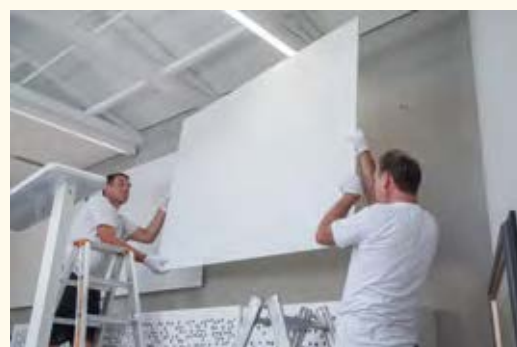
Die Absorber können bequem von einer Person bewegt und gehalten werden. Der zweite Kollege unterstützt die Positionierung und das Einhängen der Seile. (Fotos: Knauf/Bernd Ducke)
