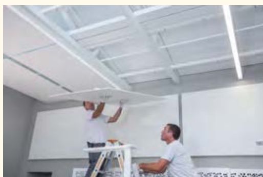
Die Wandabsorber werden mit einem einfachen Klick an den Wandmagneten befestigt und lassen sich jederzeit nachjustieren oder auch wieder abnehmen, etwa wenn der Raum dahinter gereinigt werden soll.
