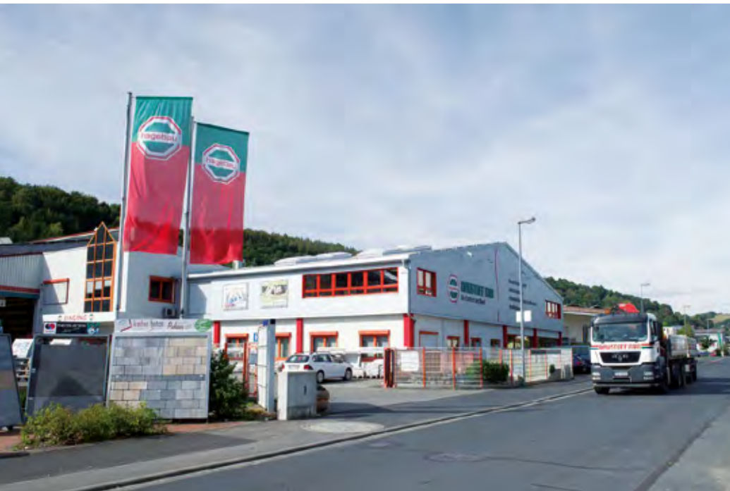
Der Hagebaumarkt in Frammersbach mit einem Teil seiner Angebotspalette.
