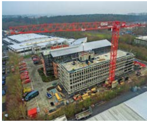
Der Rohbau des Erweiterungsgebäudes am Stammhaus der Riedel-Bau-Gruppe in Schweinfurt feierte Ende Dezember 2017 Richtfest. Foto: Volker Martin/VM Photodesign
