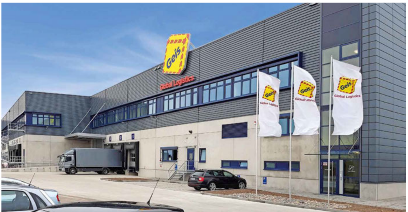
Das neue Logistikzentrum in Gochsheim.
