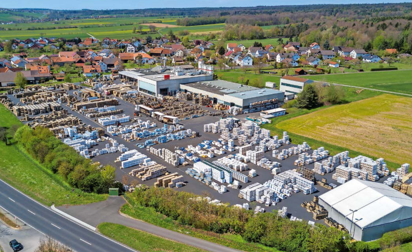
Das ACO-Werksge- lände in Oberthul- ba-Reith (Landkreis Bad Kissingen); die Wiese (rechts) soll ab 2019 als zusätz- liche Lagerfläche aufbereitet werden.
