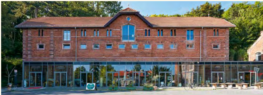
Das Bürgerbräuergelände Würzburg: Uhl baute Fassaden, Türen, Hebe-Schiebetür-Anlagen und Fenster ein. Foto: Michael Stephan Photography
