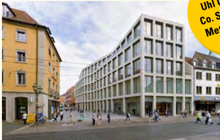
Das Gebäude in der Eichhornstraße in Würzburg: Den Einbau der Fenster und Fassaden verantwortete Uhl. Foto: Jean-Luc Valentin
