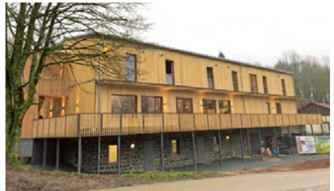
Die Bauarbeiten am Berghaus Rhön wurden im Zeitplan bewältigt. Die Kosten für das Bauprojekt blieben mit drei Millionen Euro im Kostenrahmen. Bild: Lena Pfister
