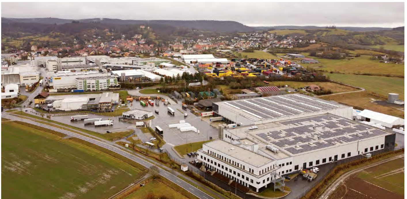
Die PV-Anlage auf dem Dach der Fränkische Group.
